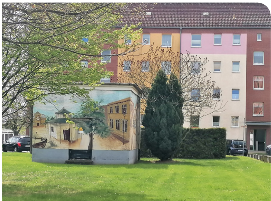
Rudolf-Tarnow-Str. 9 und 10 mit Trafohäuschen (DBR Buchenberg)
