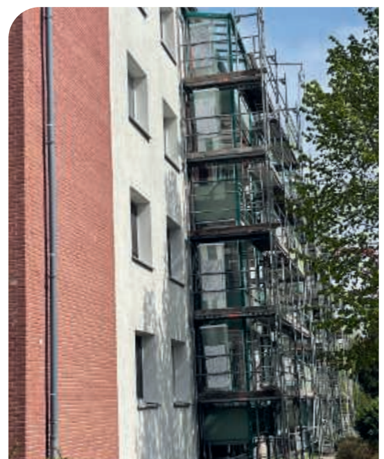
Balkonsanierung Straße des Friedens (Kröpelin)
