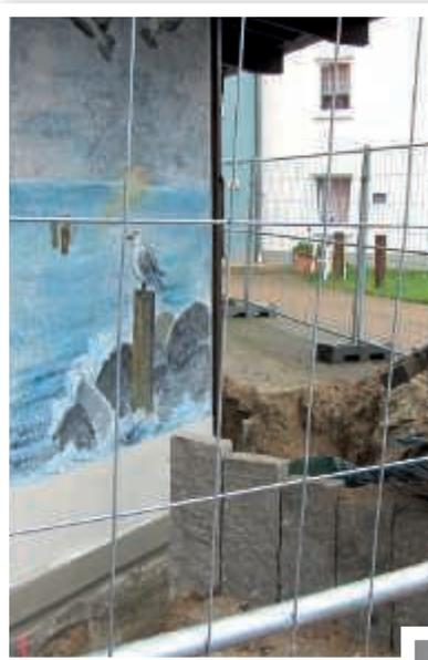
Die horizontale und vertikale Abdichtung der Außenwände entsprach nicht den anerkannten Regeln der Technik. Infolge dessen konnte Niederschlagswasser eindringen und das Holztragwerk schädigen. Mit dem Café, Einkaufsladen, Friseur, der Fußpflege und dem Treff des Johanniterhauses stellt der Pavillon einen wichtigen Bestandteil der Wohnanlage dar. Er wird rege von unseren Bewohnern genutzt und musste deshalb unbedingt wieder instandgesetzt werden.
